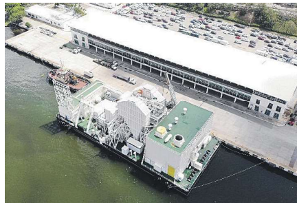
Plantas de generación eléctrica de Seaboard.
