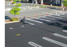
Vias y Estacionamientos Asfaltados Area 670.23 M 2
